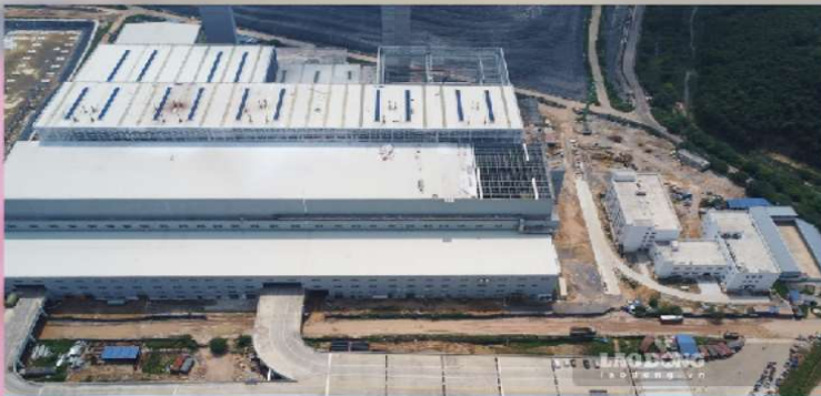
NHÀ MÁY ĐIỆN RÁC SÓC SƠN
