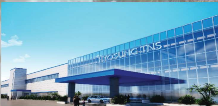
NHÀ MÁY HYOSUNG
